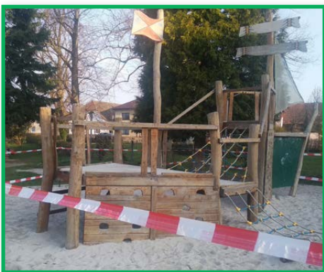
Od dubna se pracuje na opravě dětského hřiště před ZŠ. Je nutná obnova impregnačního nátěru dřevěné konstrukce, opravíme drobná poškození a vyrobíme nový koš (opravy provádí zaměstnanci OÚ).
