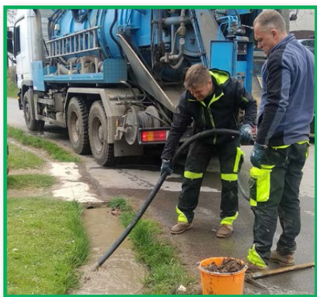
V Lišicích bylo provedeno tlakové čištění dešťové kanalizace.
