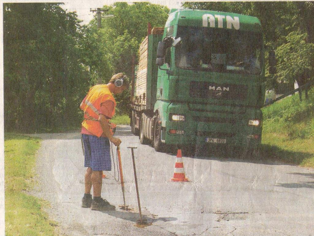
**TECHNIK MAPUJE PŘEDBĚŽNÝ ROZSAH POŠKOZENÍ VODOVODU** v Dolní Lukavici. Některé části silnice už se pod nákladními auty propadly o více než patnáct centimetrů. Foto: Deník/Gery Weschke
