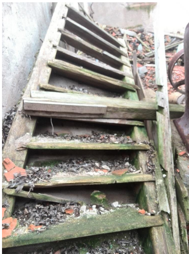
Obr. 24: dřevěné schodiště (foto J. Třísková).
